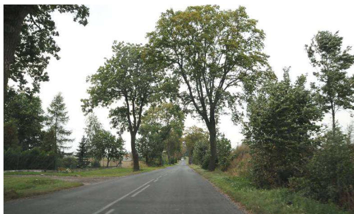
Liczne zadrzewienia przydrożne – aleja drzew towarzysząca drodze na większości analizowanego odcinka
