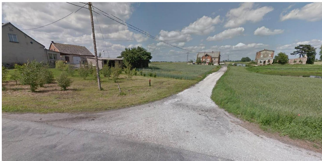
Fot. 7 Błachta – pozostałości zespołu dworsko-parkowego
